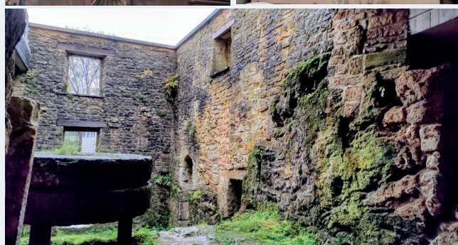
Site du Trou des fées dans les fondations sous l'église
